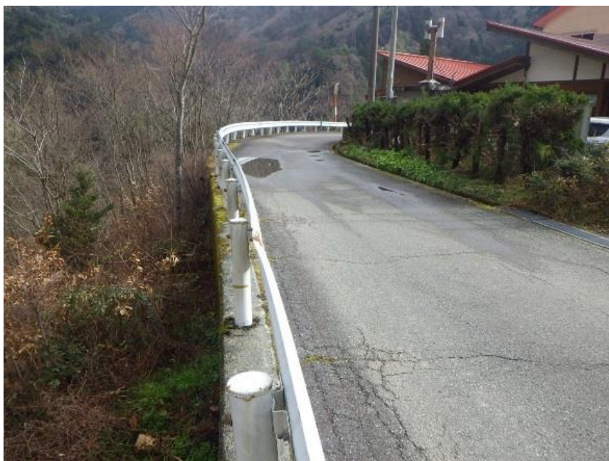
写真 1－2 外周道路の亀裂、陥没状況
