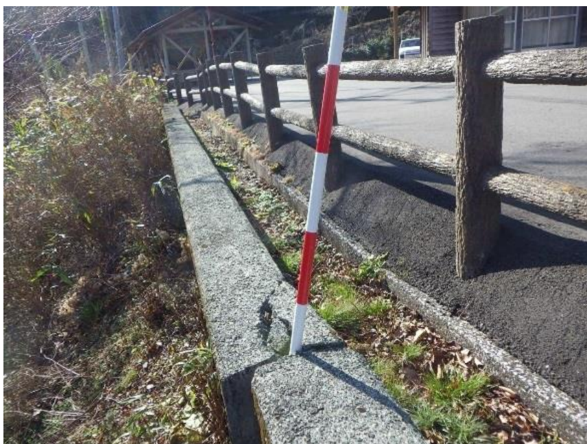
写真 1－4 水路兼用擁壁の破断傾倒
