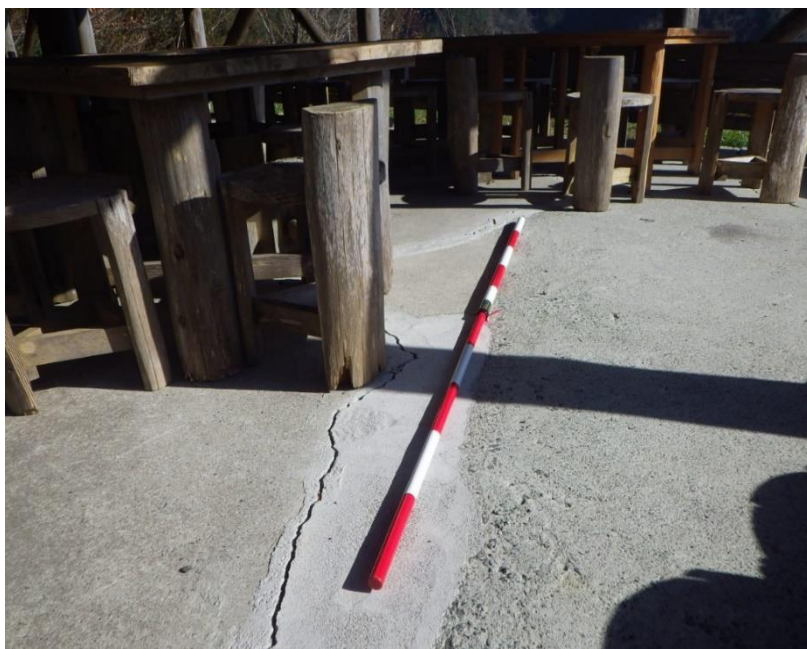
写真 1－3 ふれあいハウスの土間に生じた段差を伴う亀裂
