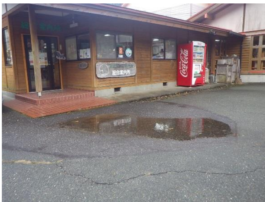
写真１－１ 管理事務所入り口周辺の地盤沈下
